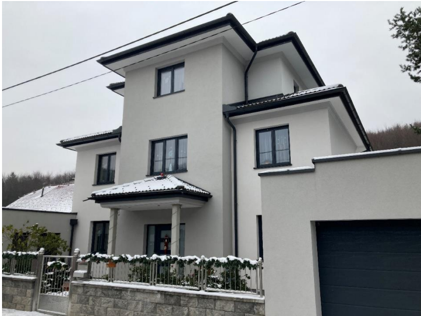
Abbildung 7: Neubau im Bereich Millöckergasse 7, Quelle: eigene Aufnahme, 12.01.2024
